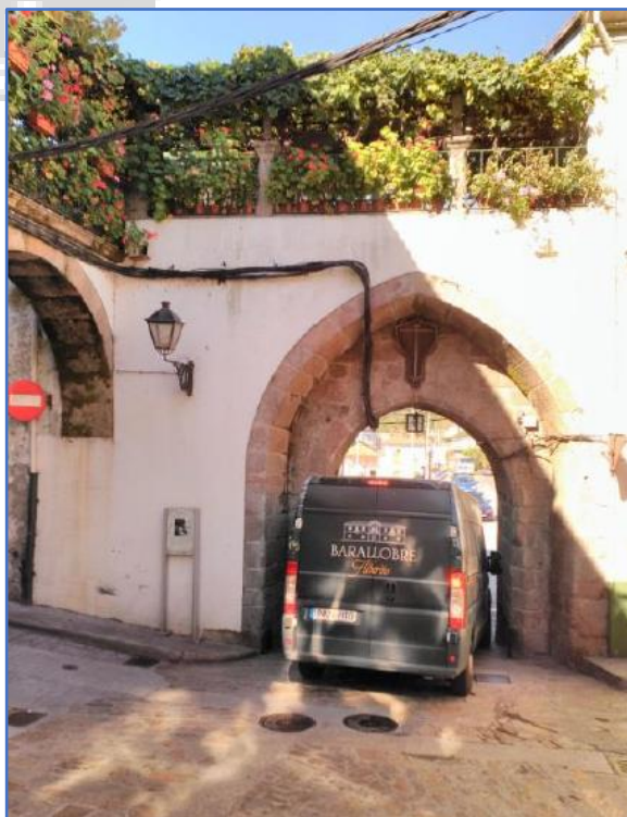
Problemas de dimensións para acoller tránsito de vehículos grandes na Porta da Ponte Nova
